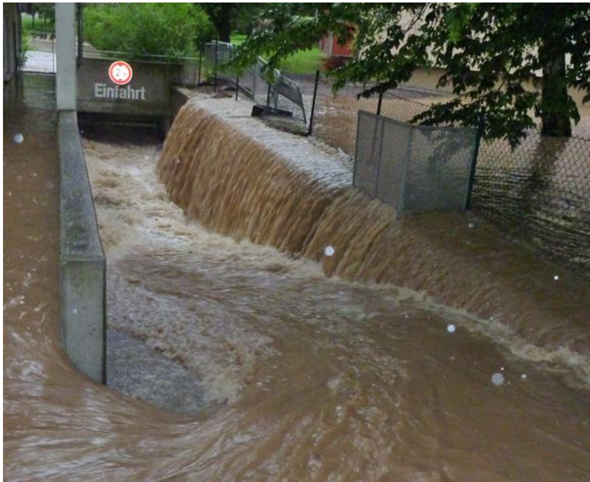
Abbildung 13: Hochwasser 2010 in Ditzingen, Tiefgarageneinfahrt (Quelle: Feuerwehr Ditzingen)
